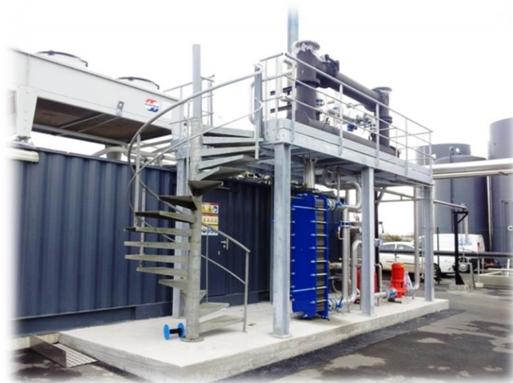
Figure 8 : Moteur de cogénération Jenbacher MS 320
